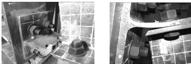
(a) 右下部 T 型件腹板断裂破坏 (b) 右上部 T 型件腹板弯曲变形
