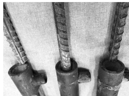
图 7 灌浆端钢筋拔出破坏 [15]
