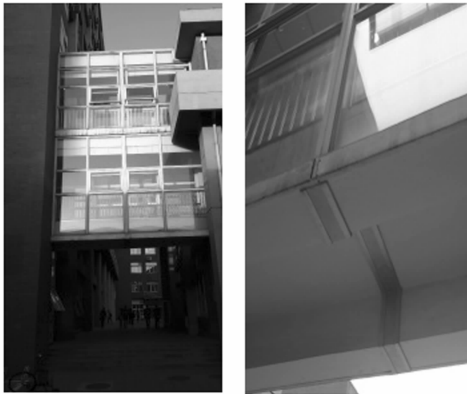
(a) 连廊 1 (b) 防震缝 1
